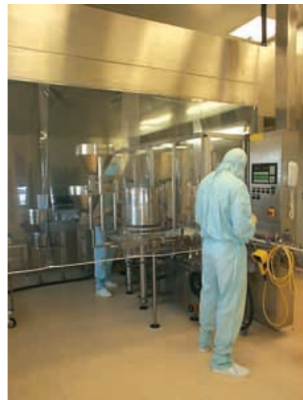
Армавирская биофабрика. Участок асептического розлива
