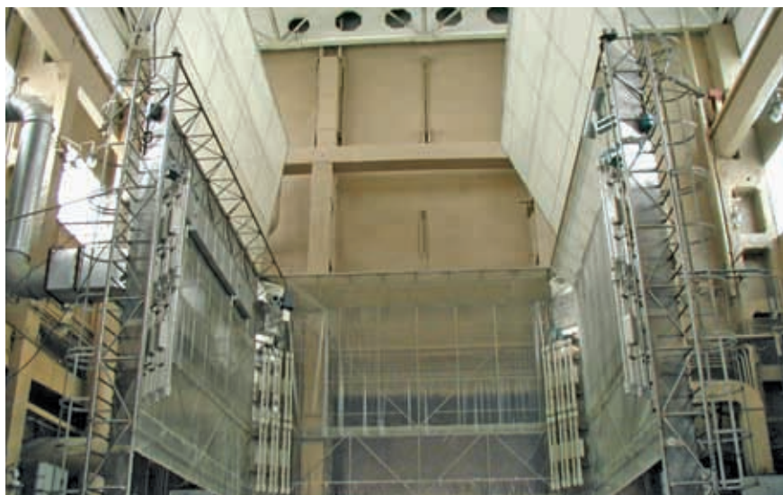
Космодром Байконур. Сборно-разборное ЧП класса ИСО 8 для заправки космических аппаратов (время сборки не более 48 часов)
